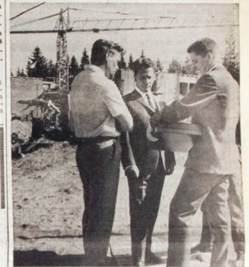
KUULOVIIKKAISTEN UUSIEN koulurakennusten kokonaistilavuus ylittää peräti 31 750 kuutiometriin. Kortepohjaan nousee seitsemän rakennuksen ryhmä, joihin julkisivut ovat poitettua tiiltä ja tummaksi käsiteltyä puuta. Rakennusryhmän suunnittelu on arkkitehtitoimisto Erkki Kantosen käsialaa ja pääurakoitsijana on toiminut Kerrostyö Oy. Harjannostajaisissa nähtiin mm. rakennushallituksen, rakennustoimikunnan ja kouluhallituksen edustajia. Kuvassa vas. Jyväskylän Kuurojen koulun johtaja op. Hannu Kalliola, erityisopetuksen ylitarkastaja Elias Niskanen kouluhallituksesta ja työmaan ylivaivontatehtävistä vastaava dipl.ins. Sakari Pitkän rakennushallituksesta.
